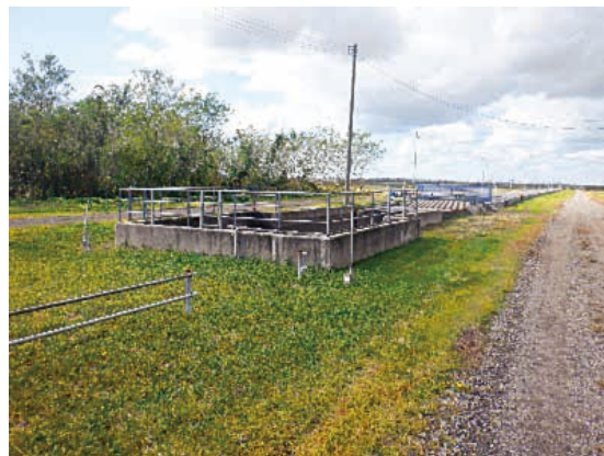
F2幹線用水路(現況)
