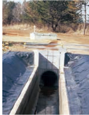
A 1 - 4 幹線用水路（工事始点部）
